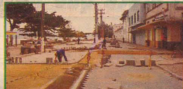
Obras de revitalização do Centro Histórico
