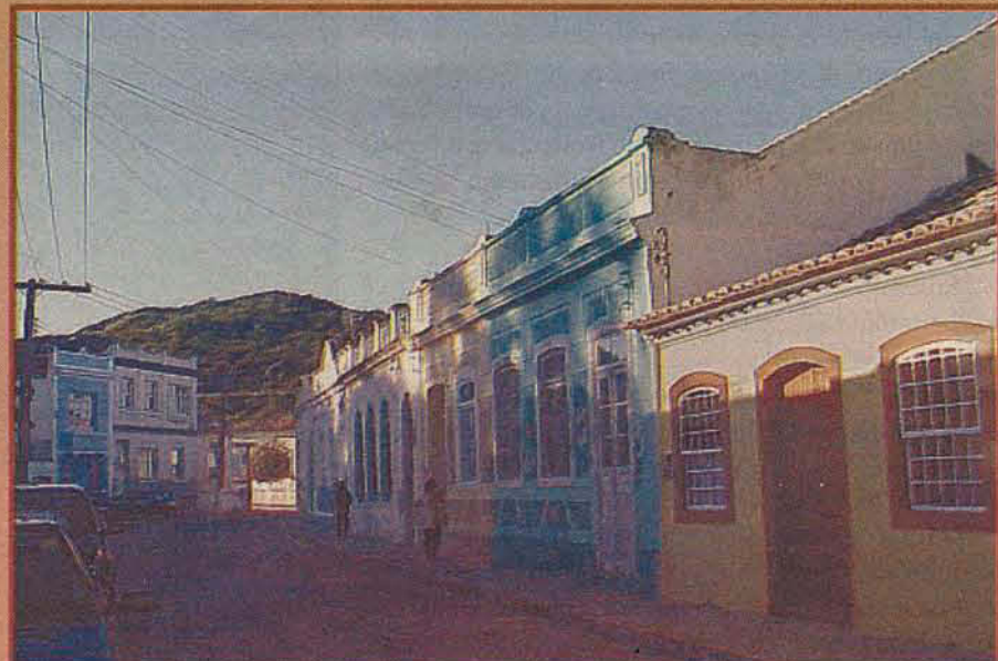
Rua Voluntário Fermiano. Nesta foto, podemos ver o perfeito alinhamento das casas que caracterizava as cidades coloniais portuguesas, fortemente marcado também pelo ritmo e seqüência das esquadrias. Esta é uma das ruas de grande importância nos primeiros traçados urbanos da cidade, que ligavam o Paço Municipal, a Igreja e a Fonte da Carioca.
