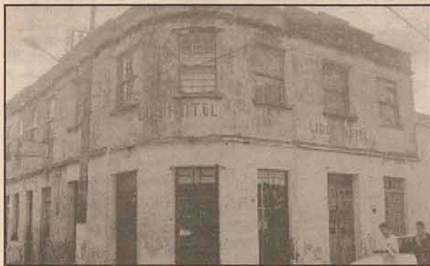
Edificação na confluência da rua Barão do Rio Branco com a praça República Juliana, nos anos 80.
