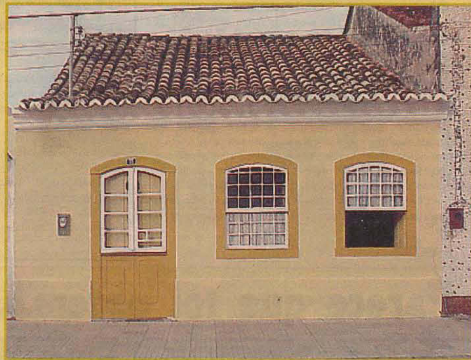
Arquitetura luso-brasileira, com vergas em arco abatido e beiral com cimalha. Tipologia adotada até fins do século XIX. Localizada na Praça República Juliana.
