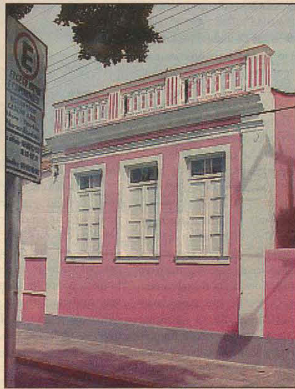
Casa com porão alto. Provavelmente alterada por aplicação de platibanda. Estilo rústico. Residência localizada na praça República Juliana.
