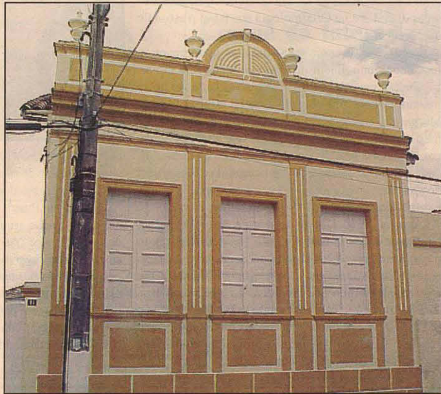
Arquitetura eclética com marcação simétrica e sacadas entaladas. Casa localizada na rua Barão do Rio Branco, centro histórico da cidade.
