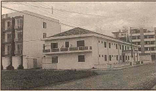
Já aparecendo as novas instalações.
