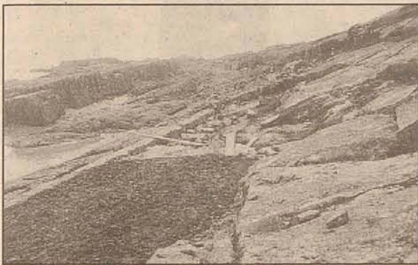
Construção da estrada para as praias do Gí e Iró, nos anos 50.
