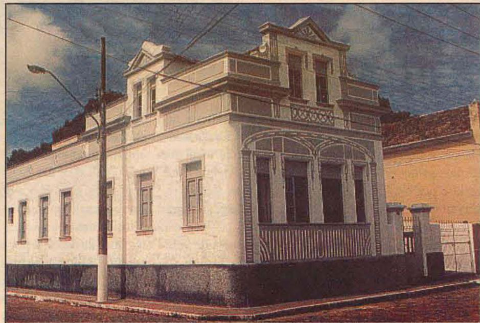
Mais uma importante construção, integrante do patrimônio tombado pelo IPHAN, no centro histórico de Laguna.
