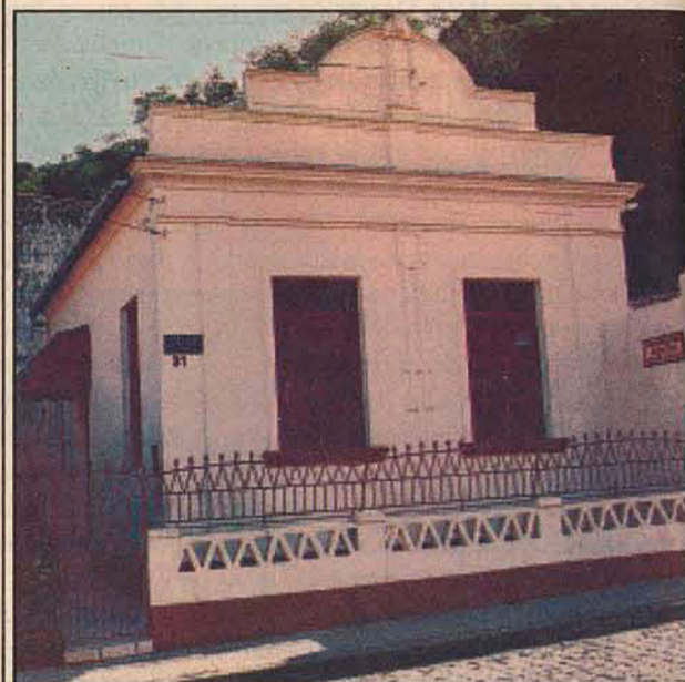
Em exemplo de conservação da arquitetura que anuncia o início do ecletismo, quando a construção já não segue o alinhamento da rua, tendo seus afastamentos frontal e lateral. Fica ali na rua José Johanny, em direção à Fonte da Carioca.
