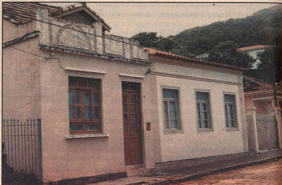
Na série que visa destacar e perpetuar o nosso importante acervo patrimonial histórico, aí estão, mantendo as linhas originais, duas edificações da travessa Luiz Nery, no centro da cidade.
