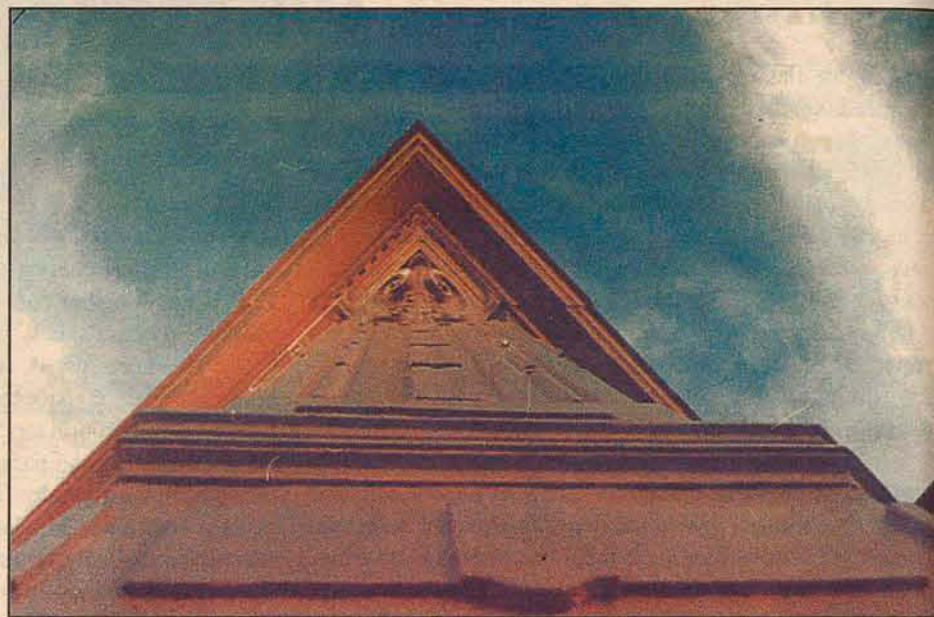
Auge do ecletismo presente no uso extremado de ornamentos, colunas, cimbalhas, frisos, capitéis, etc, característica marcante do auge econômico de Laguna, com a construção de grandes sobrados. Foto de edificação na rua Gustavo Richard, no centro da cidade.
