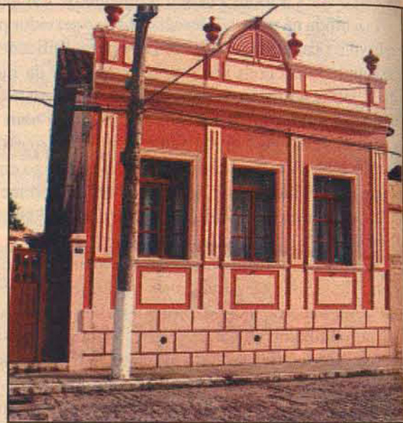
Casa eclética, com porão baixo, fachada provavelmente alterada com colocação de platibanda trabalhada. Na rua Santo Antônio.
