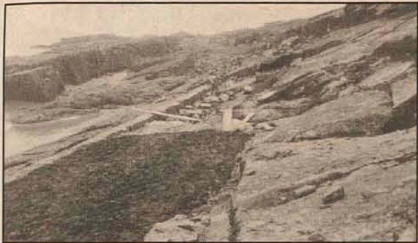
Construção da estrada que liga as praias do Iró e Mar Grosso, nos anos 50.
