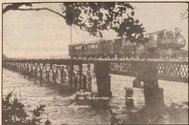
Ponte ferroviária de Cabeçuda, em 1935.
