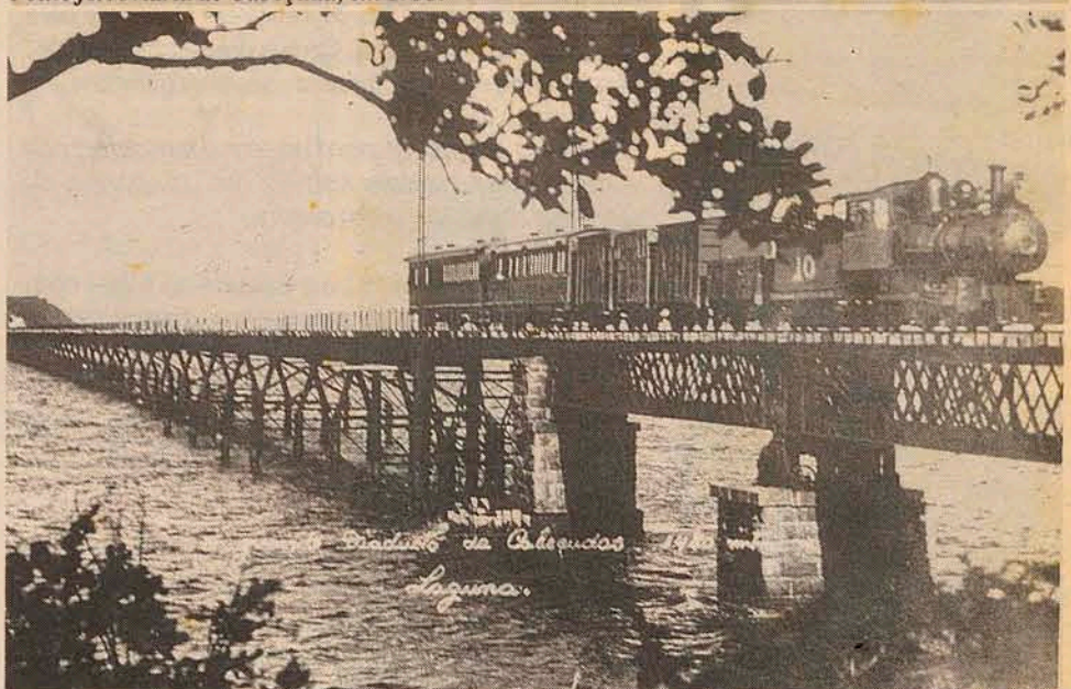
Ponte ferroviária de Cabeçuda, em 1935.
