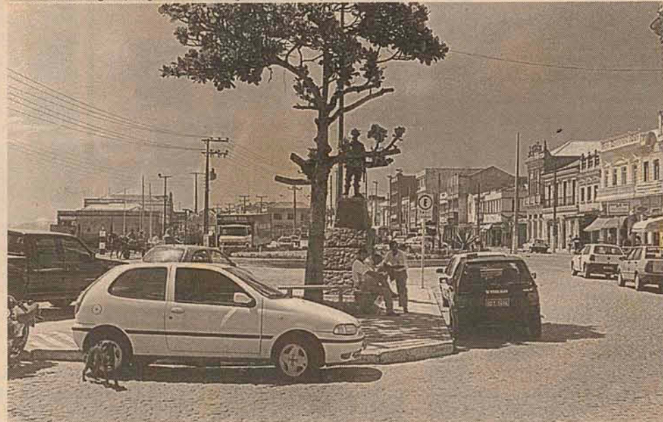
No mesmo ângulo, hoje com a estação dando lugar a um jardim.
