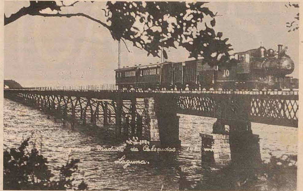
Ponte ferroviária de Cabeçuda, em 1935.
