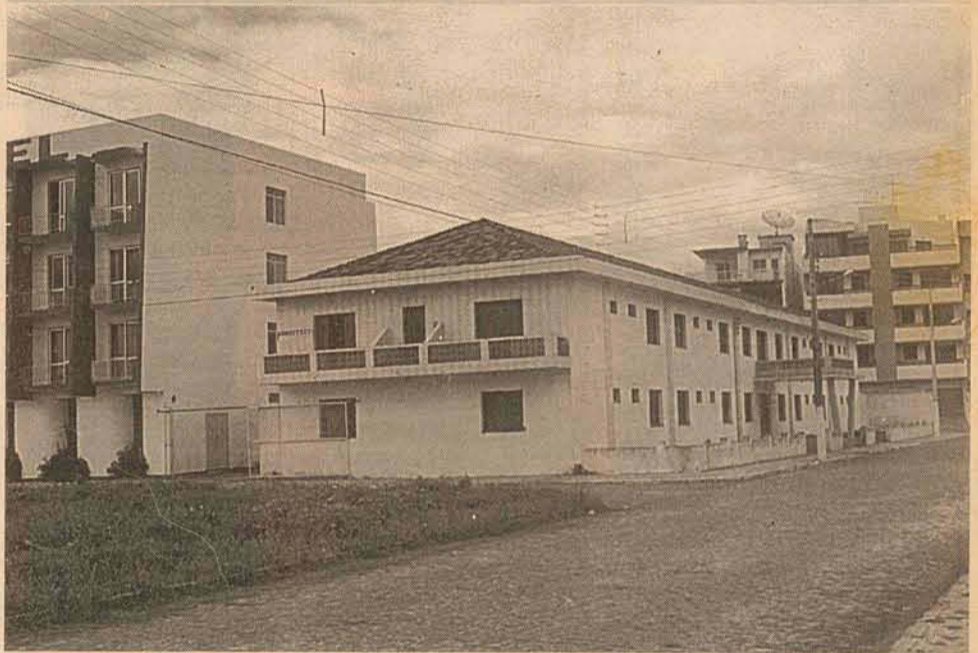
Já aparecendo as novas instalações.
