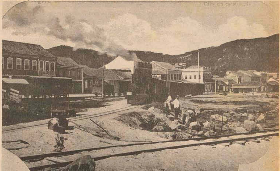
Construção do cais, no centro da cidade, no ano de 1910.
