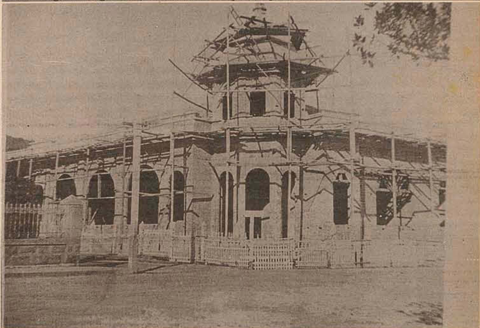
Clube Congresso Lagunense, ainda em construção, em junho de 1935.
