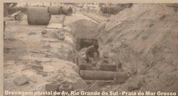
Drenagem pluvial da Av. Rio Grande do Sul - Praia do Mar Grosso
