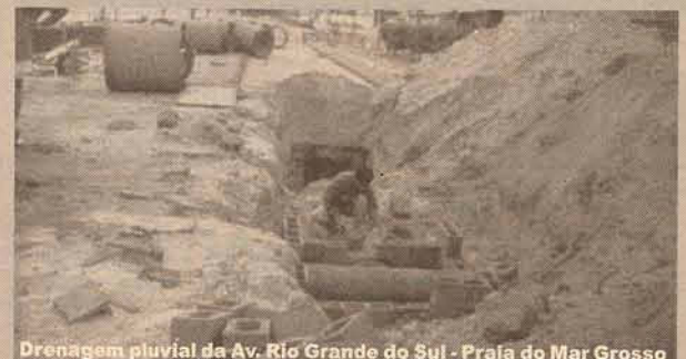
Drenagem pluvial da Av. Rio Grande do Sul - Praia do Mar Grosso
