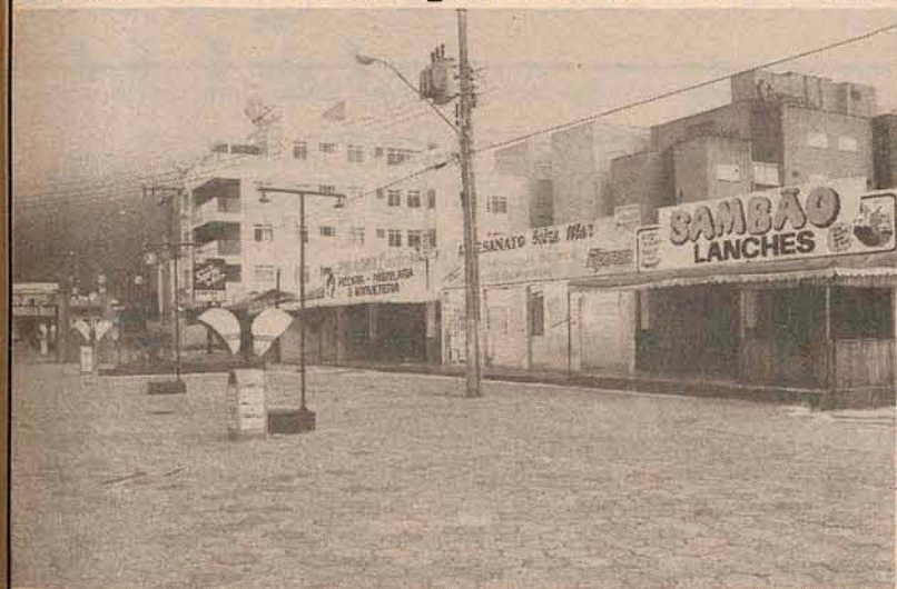
Calçadão da praia: edificações em completo abandono.
