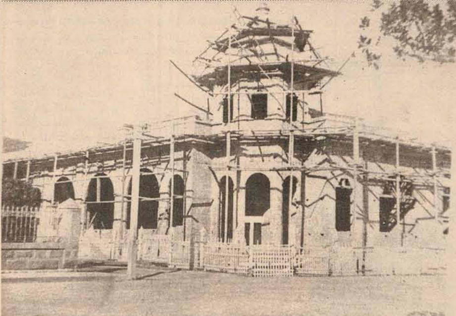
Clube Congresso Lagunense, ainda em construção, em junho de 1935.
