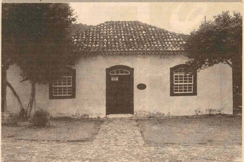
Mesmo local, totalmente reformada.
