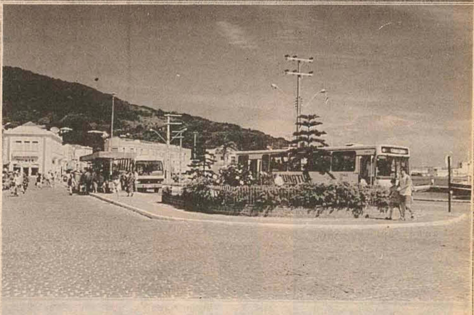
Demolido e construído um terminal urbano, aparecendo com destaque o pequeno jardim da Gustavo Richard.
