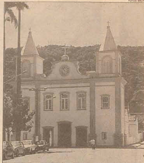
Fachada da Igreja Matriz, no centro da cidade o povo, para distinguir a Imagem, chamada a tela de Nossa Senhora da Conceição da Rocha.
