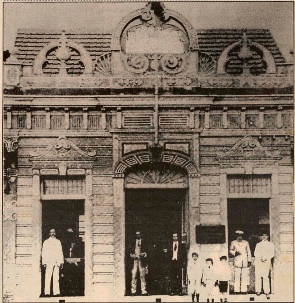
Antigo prédio, nos anos 40. Fotos: Bacha
