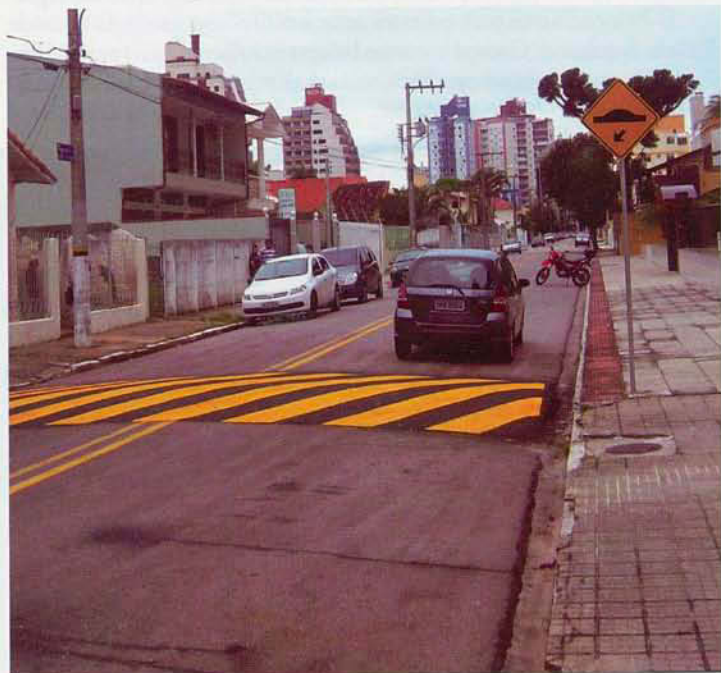
Aviso de lombada, totalmente irregular
