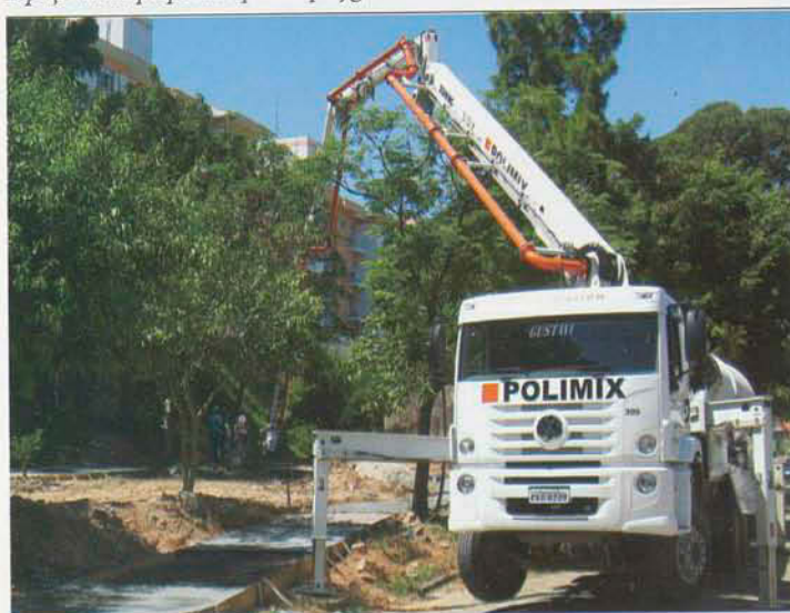
O sonho está sendo realizado, a pista para caminhadas está sendo concretada
