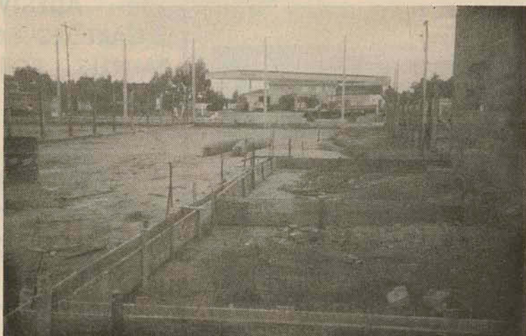
As obras de ampliação começaram
