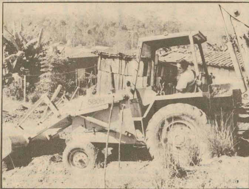
Equipamentos nas obras de saneamento do Corda Bamba
