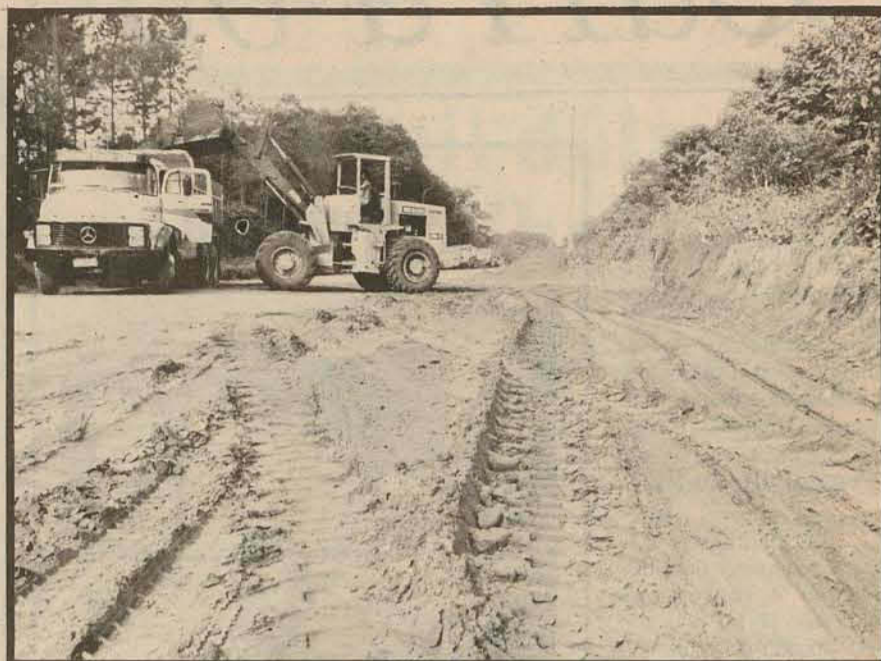
Máquinas da Engepasa na construção da SC-495 destruída em vários locais
