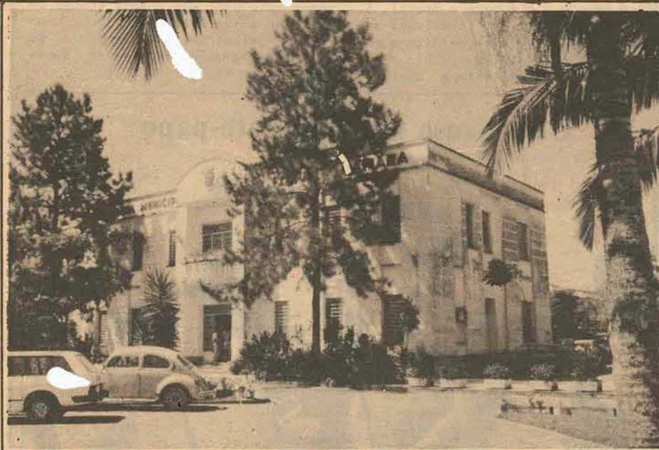
O prédio da prefeitura, onde funciona também a Câmara de vereadores e onde já esteve localizado o Fórum.
