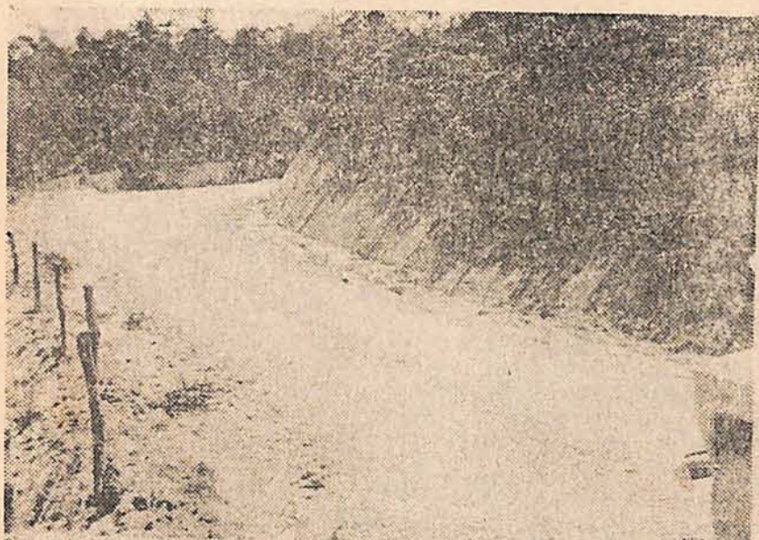
Alargamento da Estrada que liga Poço Grande a Olho Grande.
