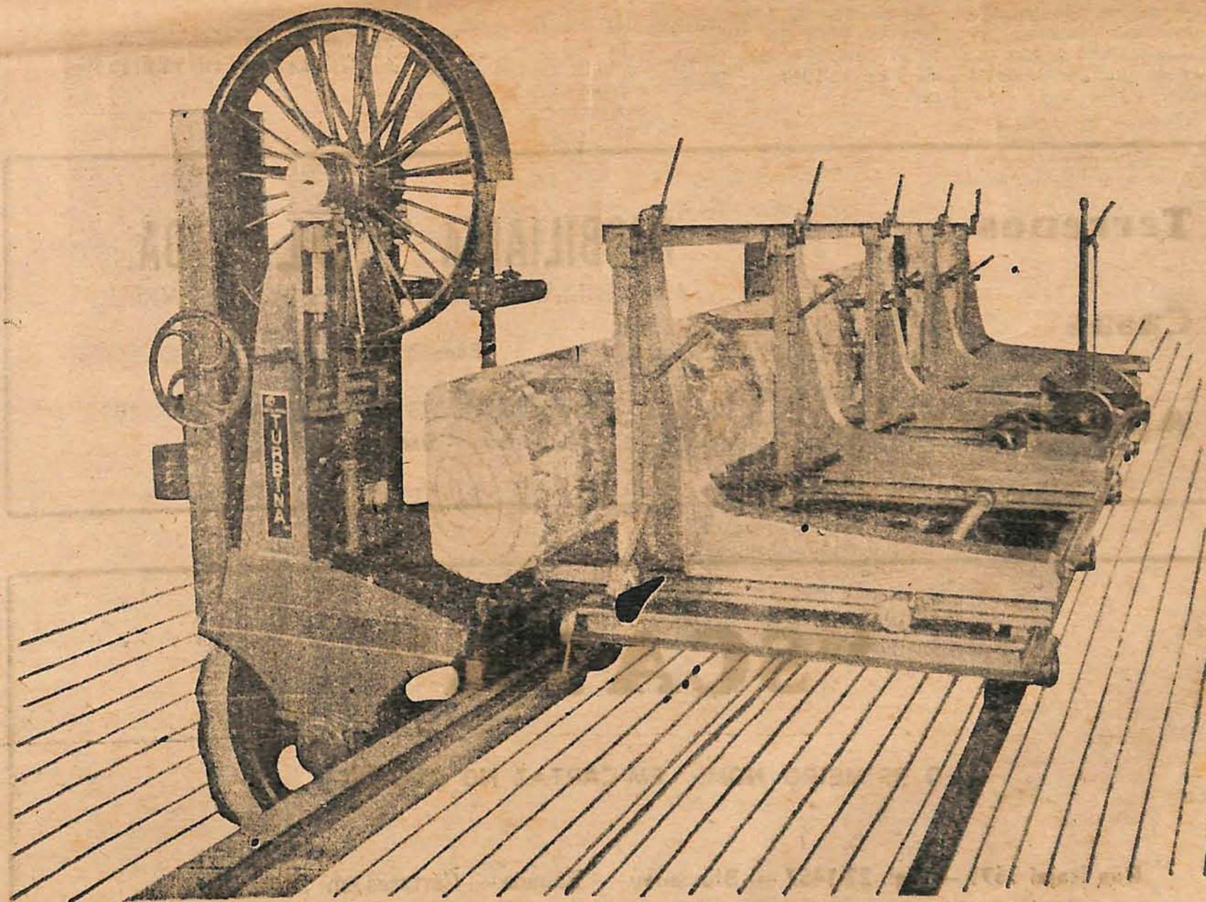
Esta é uma das Máquinas Serra Fitas de Fabricação Turbina
