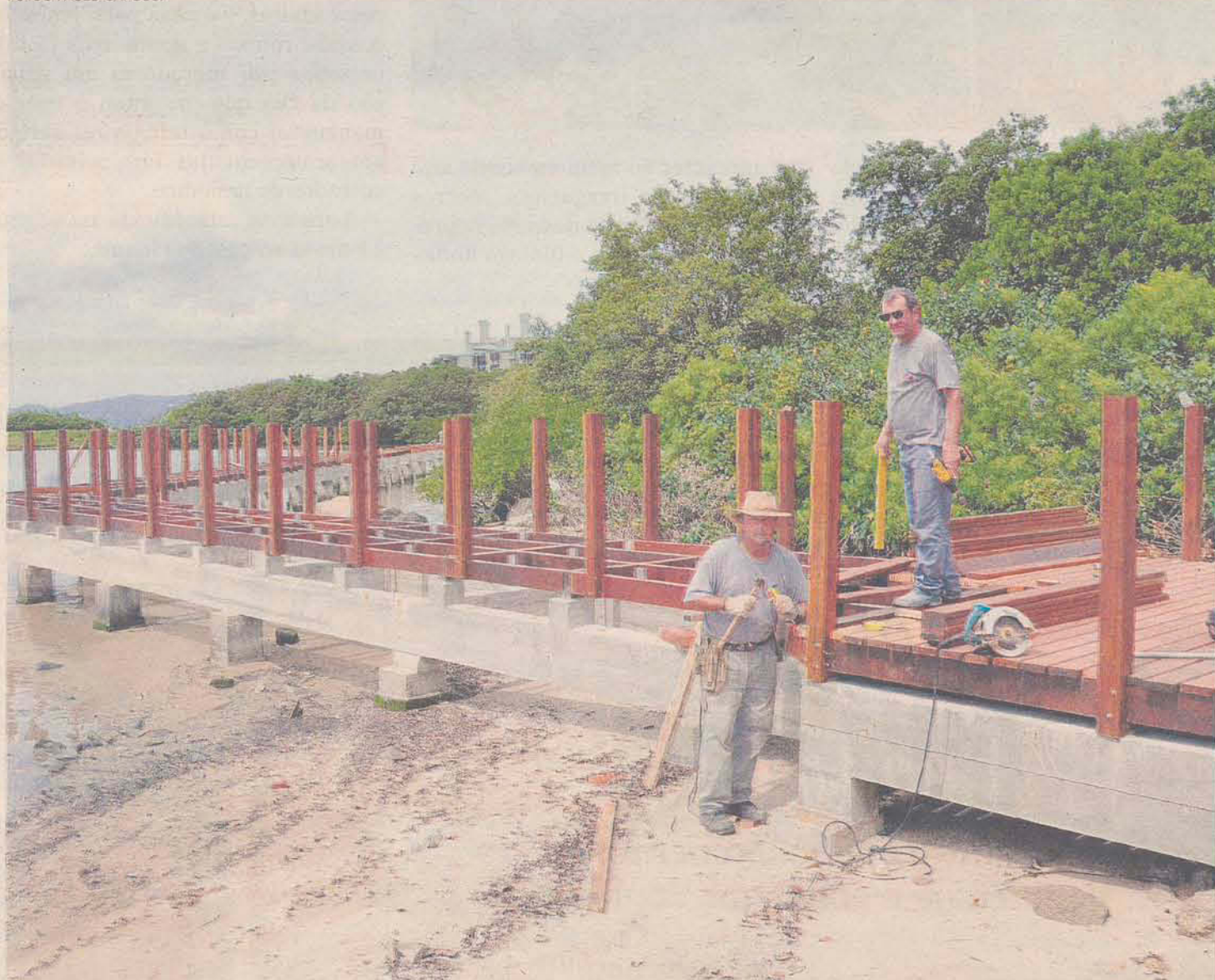
Passarela do Parque de Coqueiros e Centro Cultural do Continente recebem os últimos detalhes. Obras serão inauguradas no final de março
