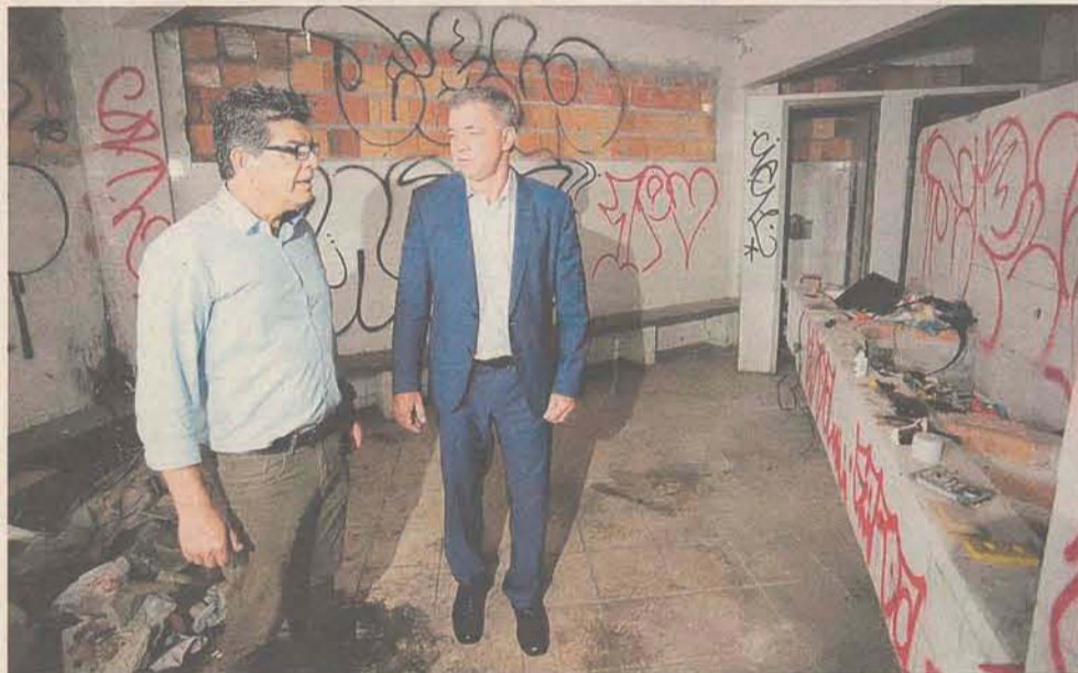
Prefeito e secretário Edinho visitam o prédio danificado
