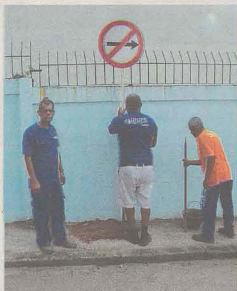
Mais de 50 placas foram instaladas
