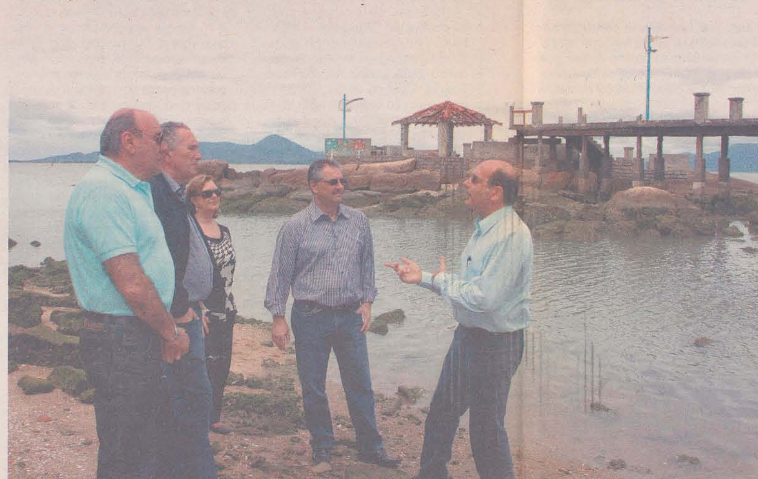
Coordenada pelo presidente da entidade, Celso Ternes Leal, força-tarefa da ACE visitou o lugar e garantiu que estrutura pode ser recuperada
