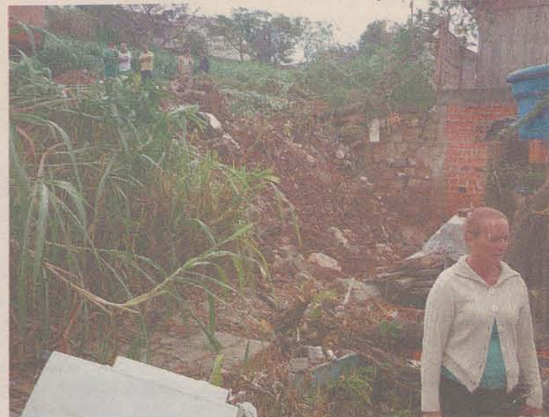
LIXO: barranco com cinco metros derrubou muro de Santa Piva
