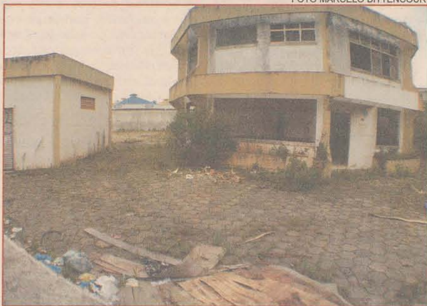
ABANDONO: unidade será erguida no antigo galpão (esquerda) da Casan
