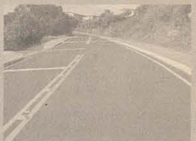
*Acesso a Quilombo Pavimentação de 2,4 km do acesso que liga Quilombo à SC 468
