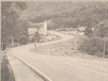
SC 413 (Rodovia do Arroz) Pavimentação de 23 km ligando Joinville a Jaraguá do Sul
