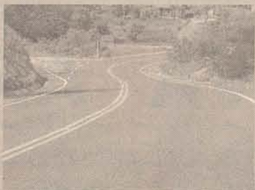
SC 443 Pavimentação de 8 km ligando Morro da Fumaça a Sangão
