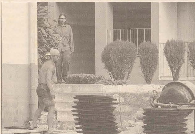
SISTEMA DE ESGOTO: obra do condomínio deverá estar concluída em dois meses
