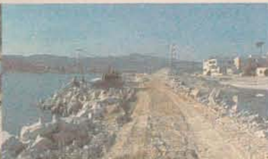
Construção da Beira-mar Continental (trecho Ponte Colombo Sales - Ponta do Leal); término previsto para final de 2007.
