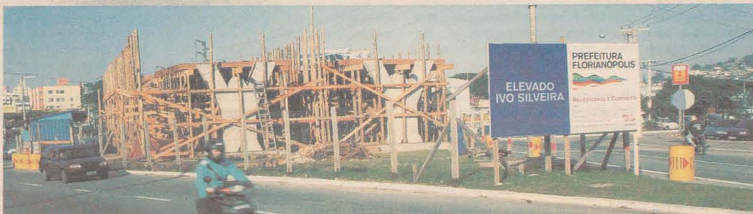
Elevado da Ivo Silveira: Obra em andamento, término previsto para agosto de 2007.
