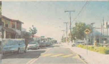
Operação Tapete Preto: Drenagem e pavimentação de mais de 200 ruas.
