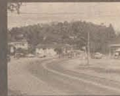
SC-418 Reabilitação Pomerode - BR-470 (em finalização)
