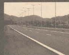
Acesso a Penha - BR 101 Pavimentação
