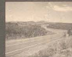
SC-427 Pavimentação Rio Rufino - BR-282
