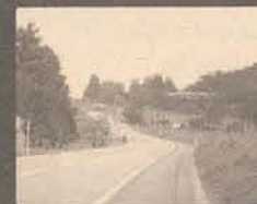
SC-426 Pavimentação Trombudo Central - Braço do Trombudo
