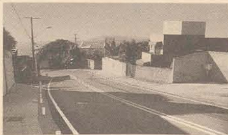
Operação Tapete Preto: mais de 177 ruas com nova pavimentação.
