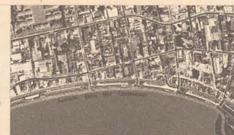
Construção da Beira-Mar Continental: ordem de serviço liberada.
