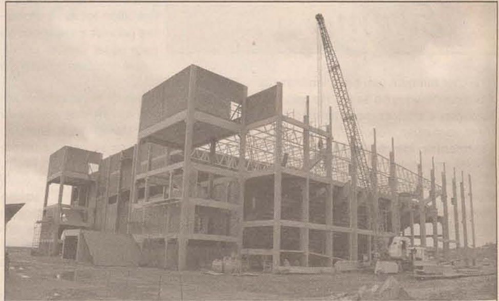
•Construção da Arena Multiuso de São José.
