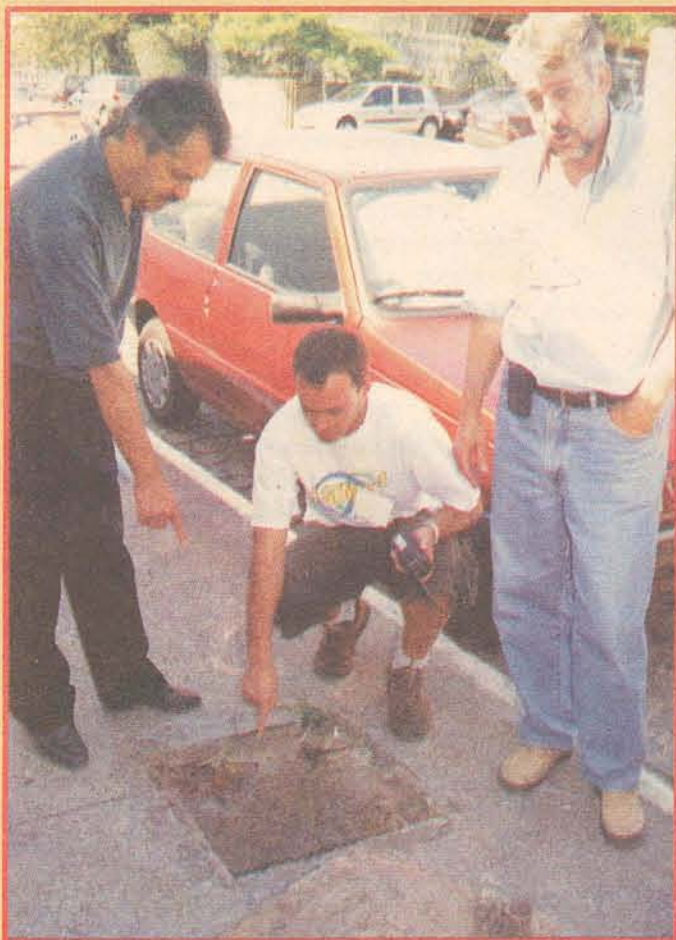
OPERAÇÃO: Técnicos da Casan fiscalizam sistema de esgoto em Itaguaçu
