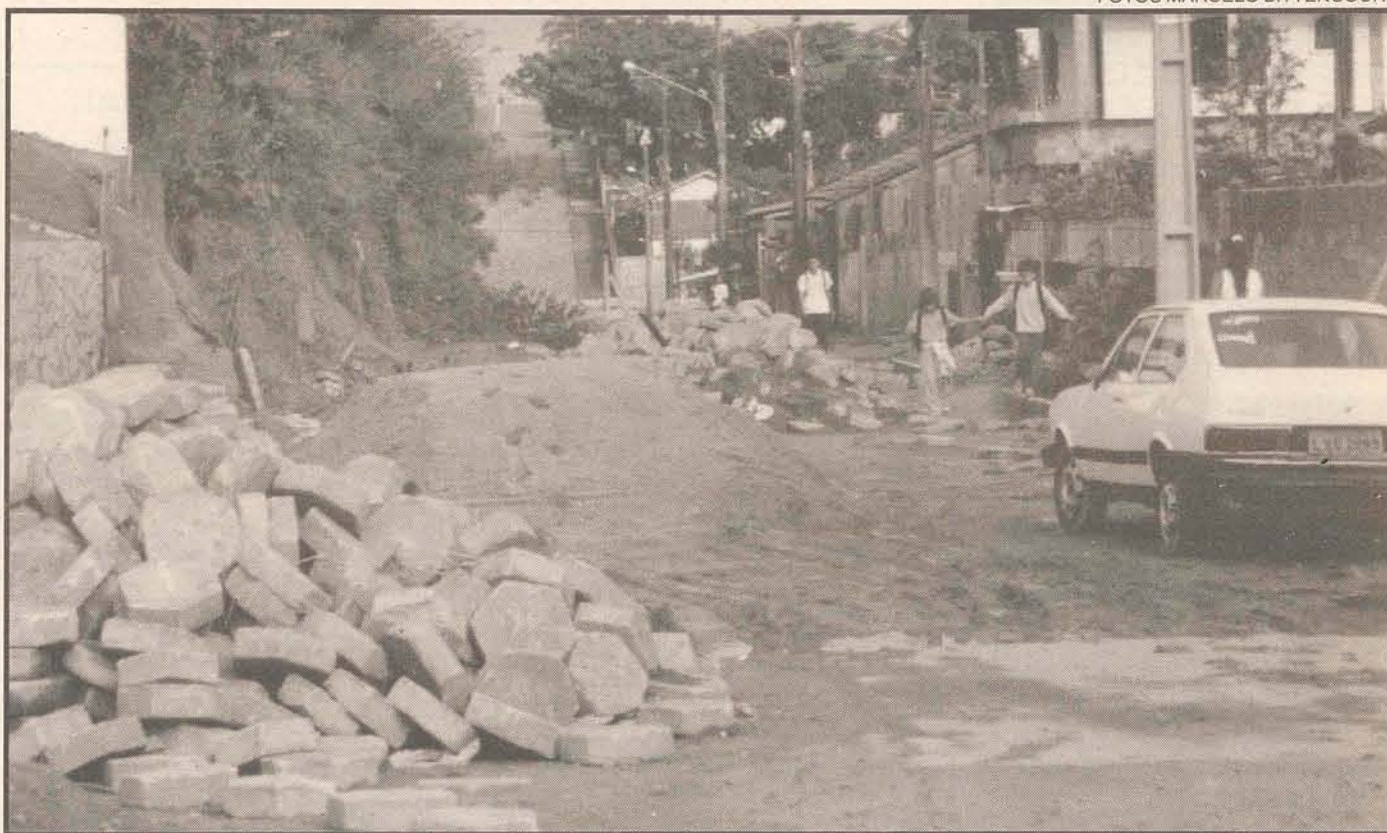
RECUPERADAS: Lajotas das vias que receberam asfalto serão utilizadas
