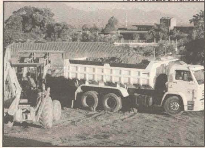
OBRA: edifício de nove andares na rua Ivo Reis Montenegro
