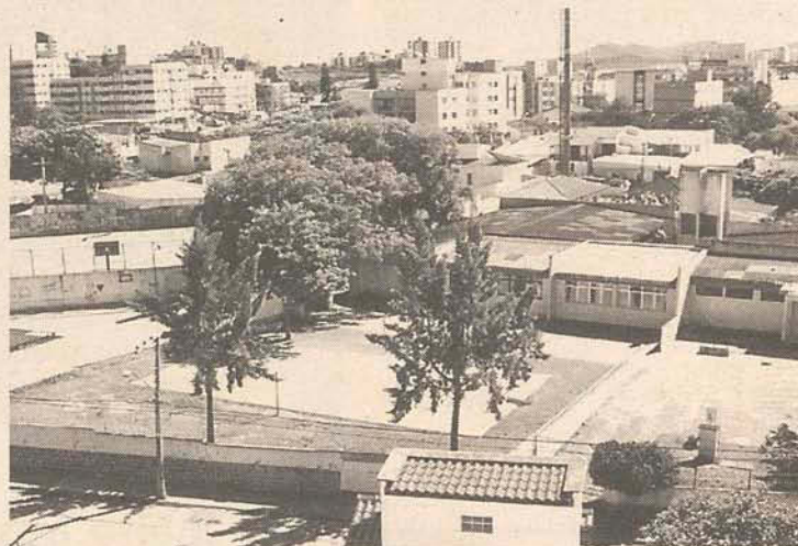
MELHORIAS: Construção do NEI vai possibilitar a ampliação da Escola
